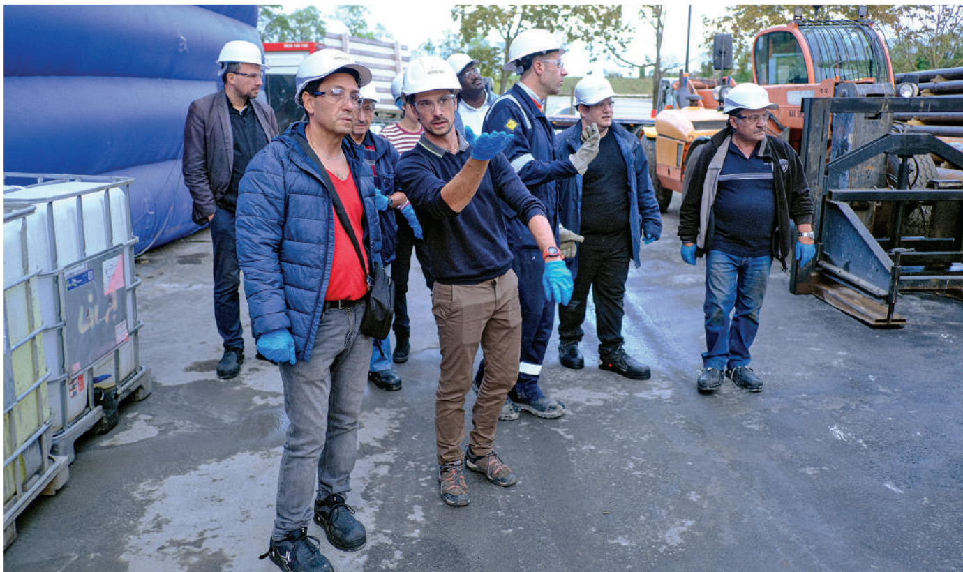
Des Villetaneusiens visitent le chantier de forage à Saint-Denis qui préfigure l'installation qui sera déployée sur les terrains du gymnase Jesse-Owens. (© Erwann Quéré)
